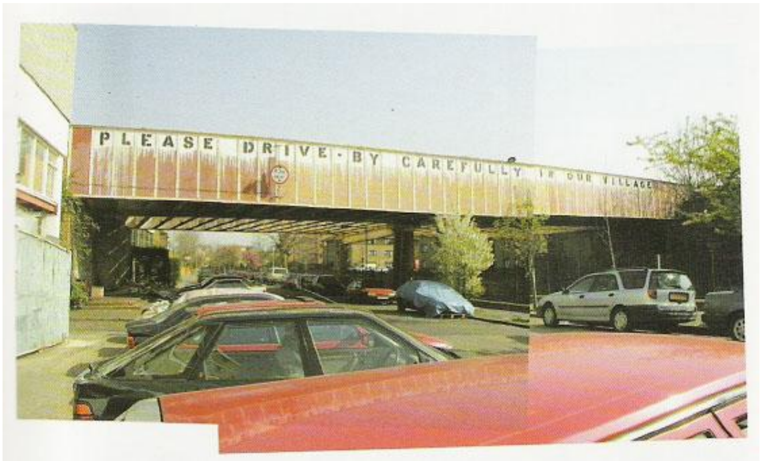
Puente ferroviario de Kingsland Road Hackney.
